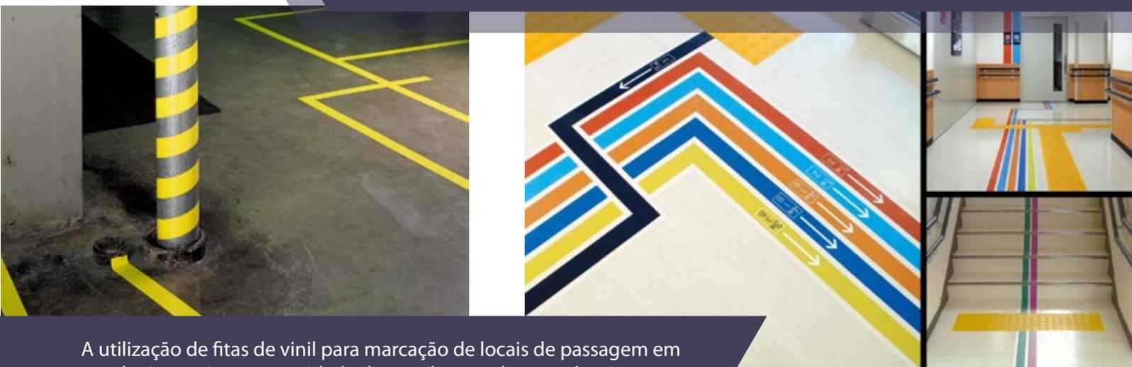
A utilização de fitas de vinil para marcação de locais de passagem em vez de tinta evita a necessidade de ventilar os solventes das tintas e, visto que as fitas de vinil podem ser removidas de forma fácil sem deixar resíduo, também são uma opção mais rápida, versátil e económica do que a pintura.
